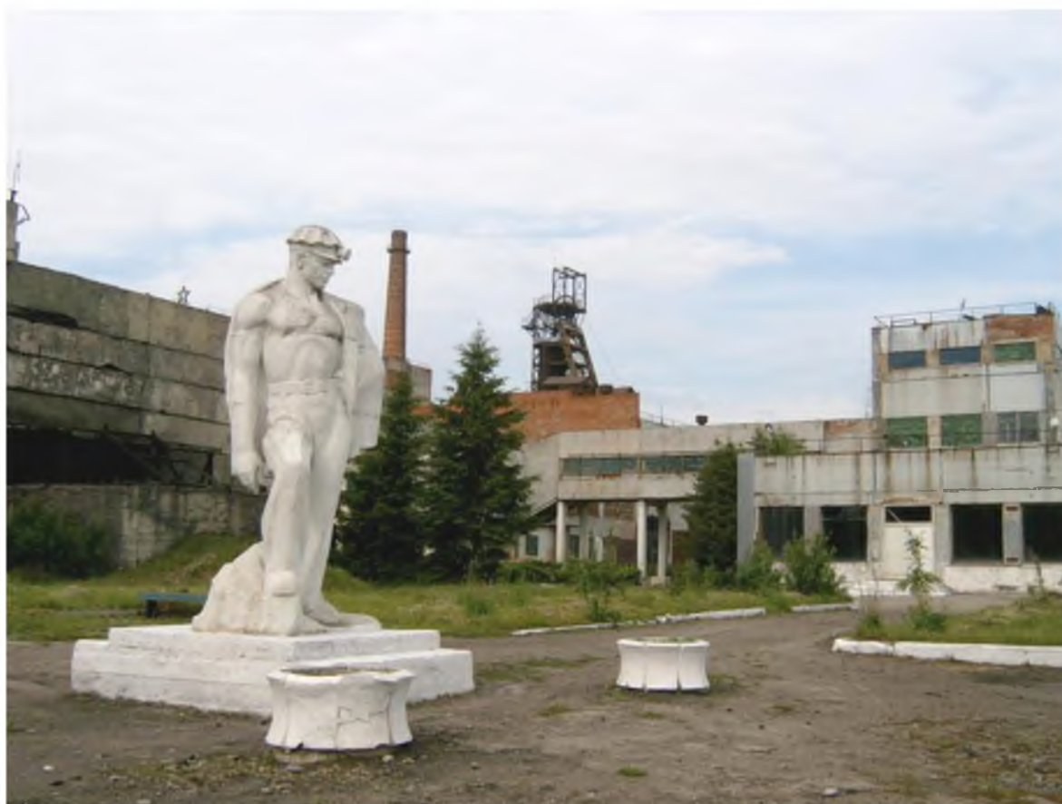
Промышленная площадка последней из закрытых шахт Подмосквовного угольного бассейна – шахты «Бельковская», добыча угля на которой была прекращена в 2007 году (фото А.А.Рожкова)
